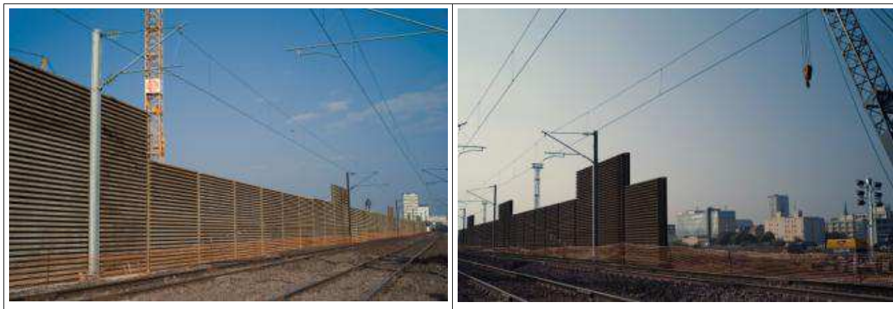
Figure 3 : écrans acoustiques à Metz.
