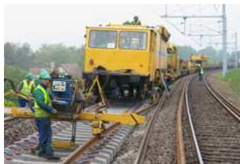
Longs Rails soudés sur traverses béton
